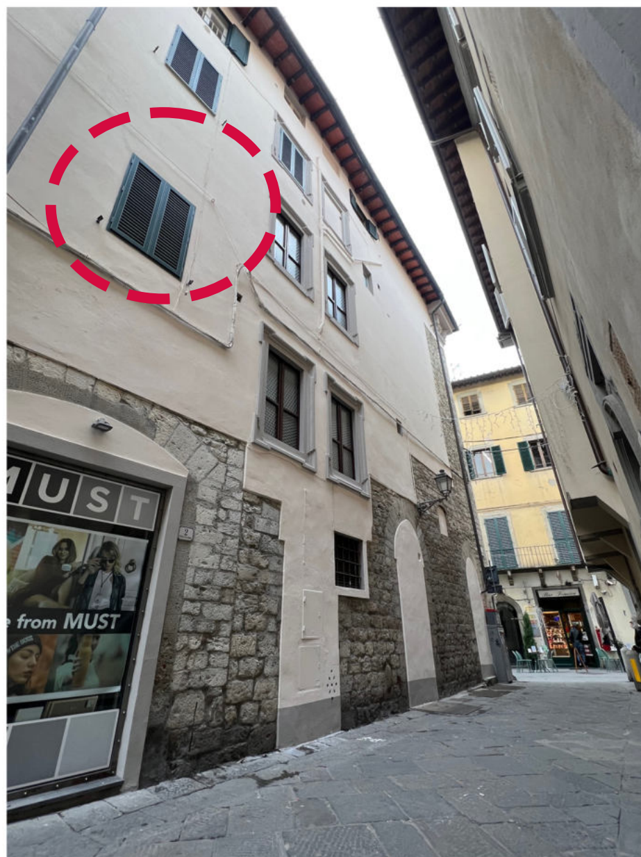
Vista della facciata da Via dell'Academia tra i civici 2 e 4
