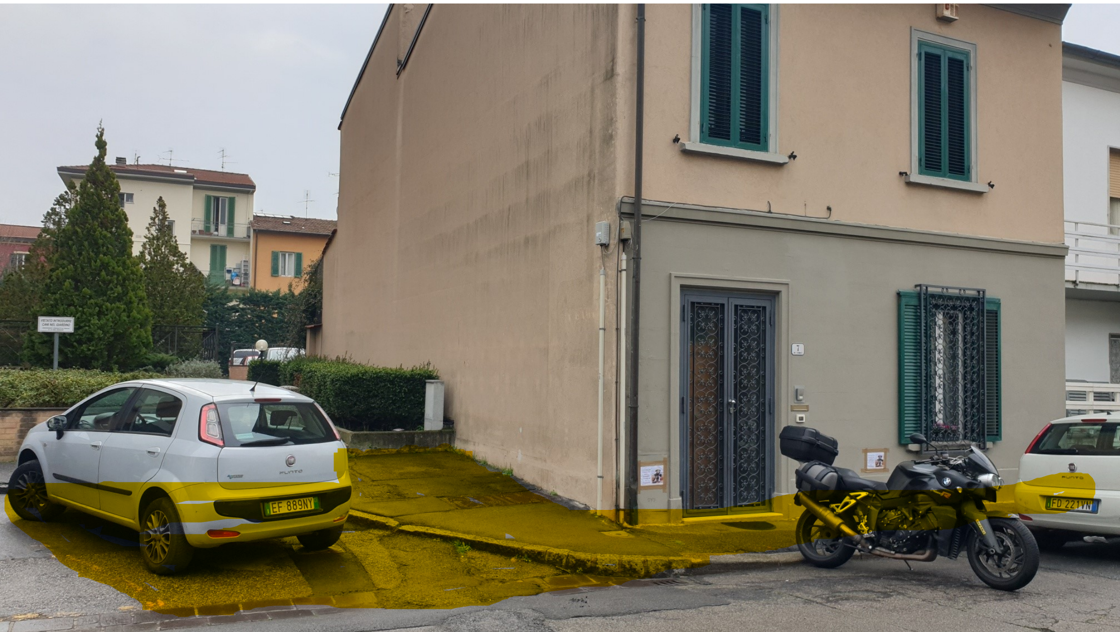
MARCIPIEDE FRONTE STRADA PROFONDITA' ML. 1.55, PONTEGGIO MONTATO TUTTO SUL MARCIAPIEDE, E OCCUPAZIONE DI UN PARCHEGGIO PER CANTIERE
